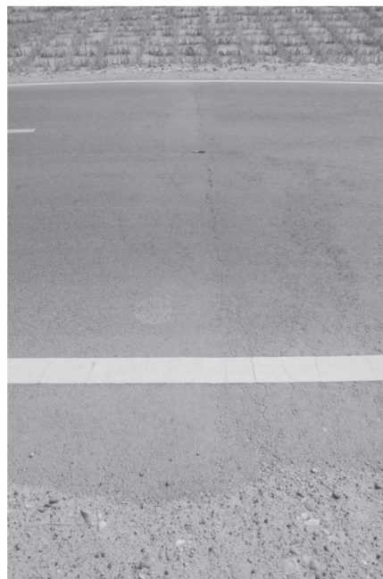
图 1-1 阿和沙漠公路横向裂缝
