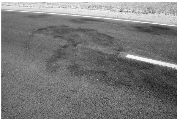
图 1-4 阿和沙漠公路路面层间结合状况
